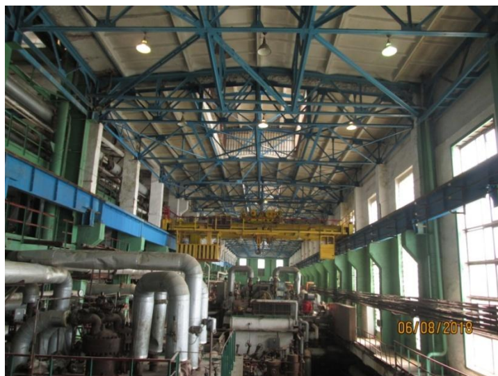
Figura 10. Imaginea iluminatului existent al sălii de mașini
